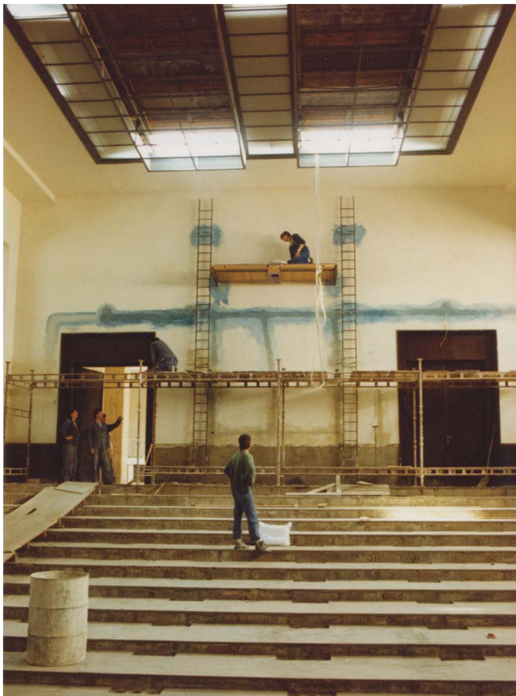
56 | Auditorium maximum – rekonstrukční práce (květen 1994)
